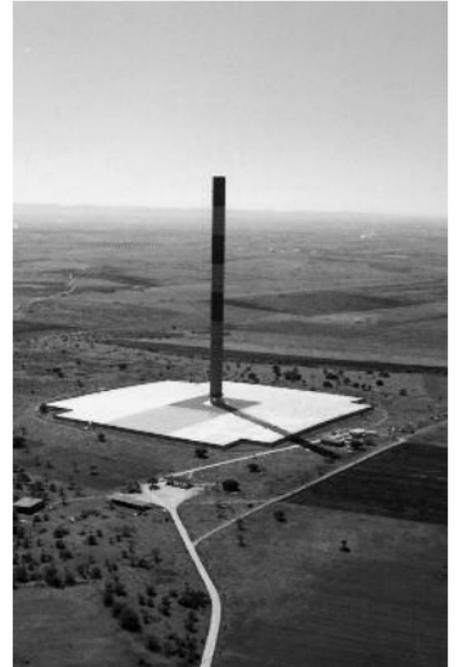
Versuchsanlage eines Aufwindkraftwerkes
